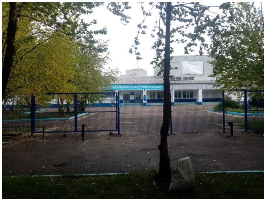
Центральные ворота прохода обучающихся Корпус «А»
